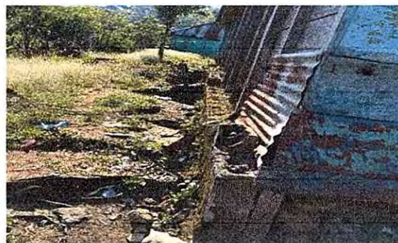
Foto 4: Muestra de cimiento de una de las aulas del establecimiento.
