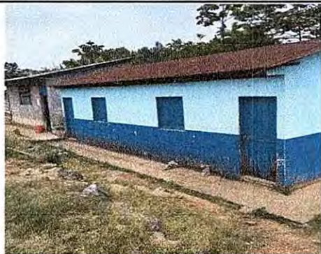
Foto 1: Muestra del techo, puertas, ventanas de un aula y de cocina del establecimiento.
